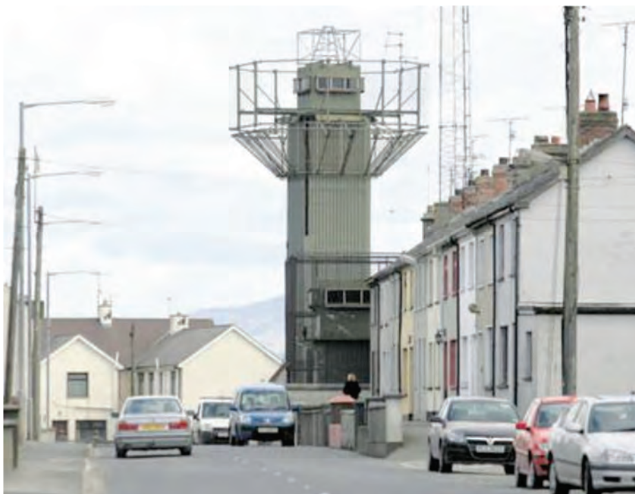
Illustration 14 : Le poste d'observation de Crossmaglen Square. Source © The Belfast Telegraph
